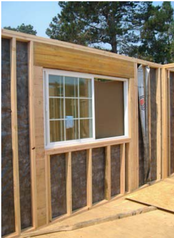
建物内部からの写真です。ミルガードの窓がすでに取り付けられているのがわかります
