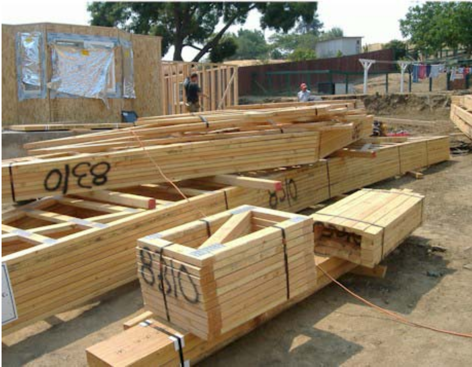
この写真は外壁を建てているところで、手前にこれから取り付けられる各種のトラスが写っています
